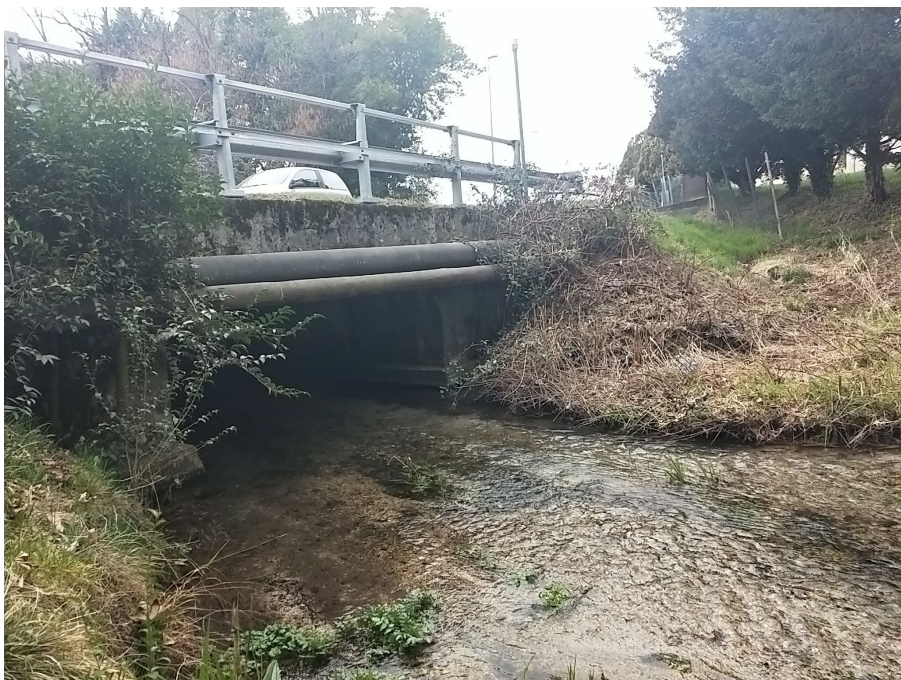
Figura 12 – Vista del ponte carrabile esistente (lato di inserimento della passerella)
