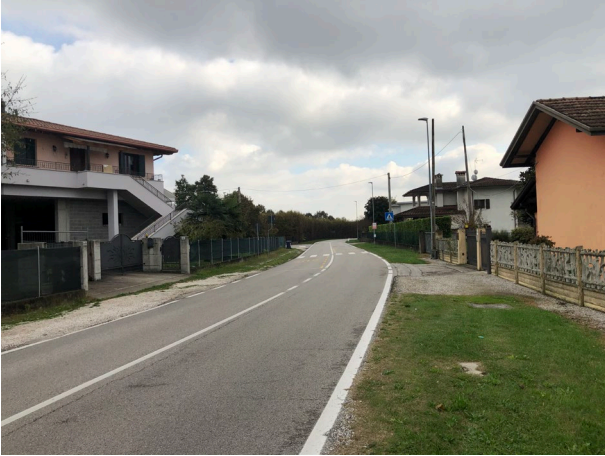
Via alla Ferrovia – lotto 1
