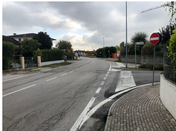
Via alla Ferrovia – lotto 1
