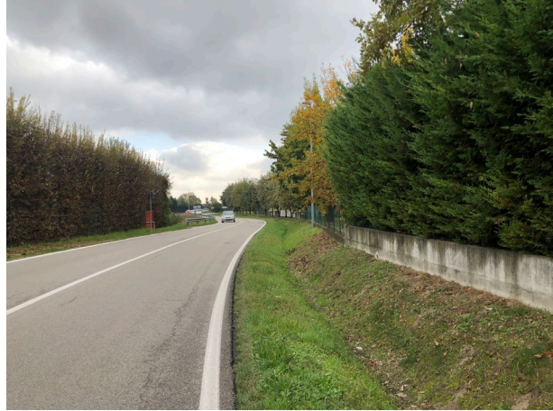
Via alla Ferrovia – lotto 1
